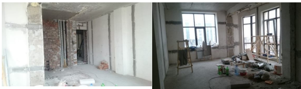
Рисунок 2. Процесс подготовительных работ (снятие перегородок)
