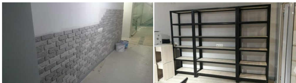
Рисунок 4. Внутренняя отделка стен и подготовка помещений
